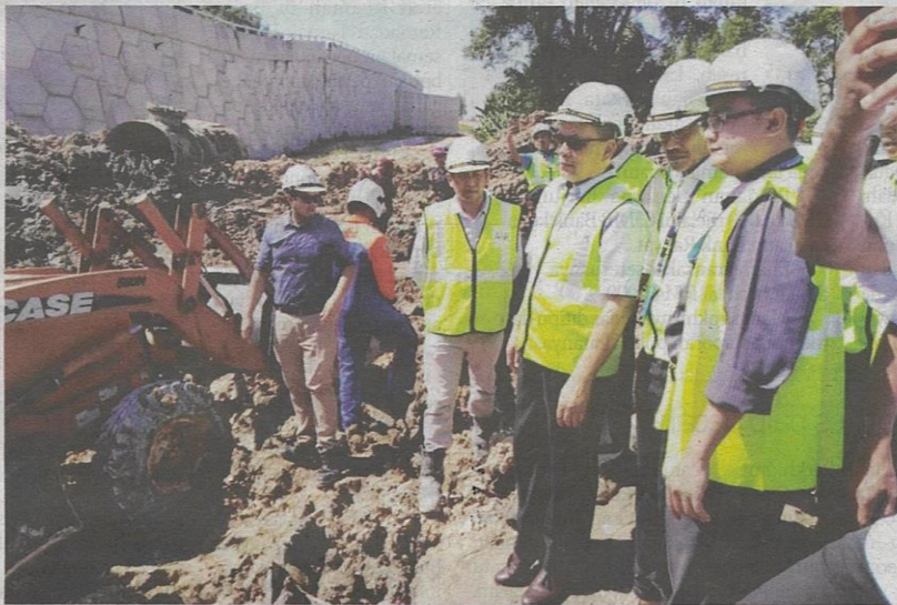
Izhah (tiga dari kanan) meninjau kerja-kerja pembaikan tiga paip utama yang pecah berhampiran projek pembinaan Lebuhraya West Coast Expressway (WCE) Banting-Taiping, semalam.
